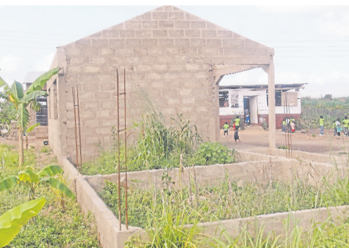
Neben dem Schulhaus für drei Klassen wurde mit dem Bau eines zweiten Gebäudes begonnen.
